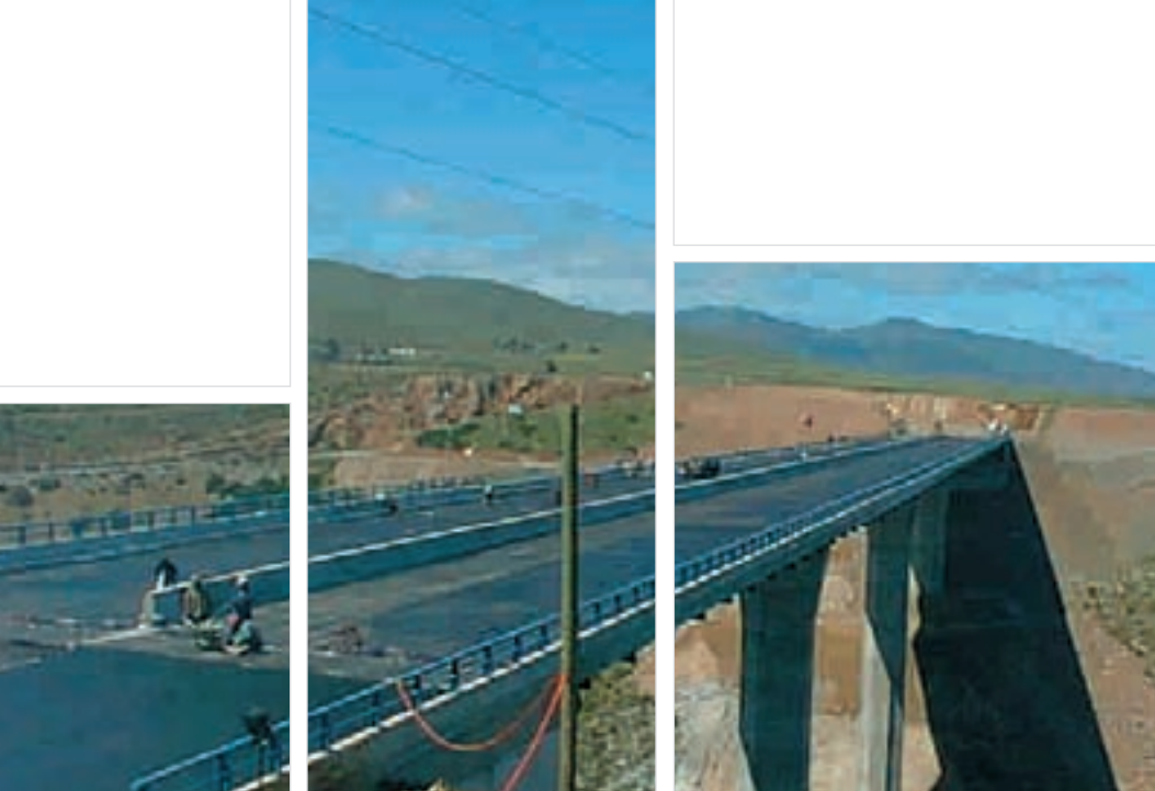
Viaducto de Amolanas • Chile
